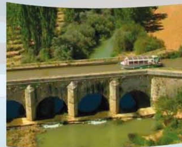
El canal con sus 207 km. y su forma de Y invertida, recorre las provincias de Palencia, Burgos y Valladolid, con una anchura que oscila entre los 11 y 22 metros y una profundidad entre 1,80 y 3 metros.
